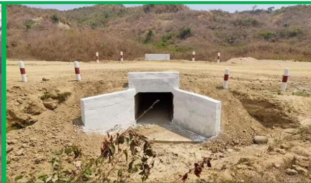
ဥဒေါင်း-ညောင်ချောင်းတောင်ကျော်လမ်း Box Culvert တည်ဆောက်ခြင်းလုပ်ငန်းဆောင်ရွက်နေပုံ
