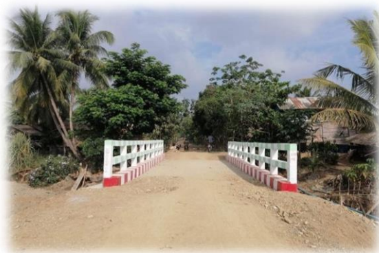
ရမ်းဗြဲမြို့နယ်၊ မြေပုံပိုက်ဆိပ်ကျေးရွာ ကွန်ကရစ် တံတား(၂)တည်ဆောက်ခြင်းလုပ်ငန်း
