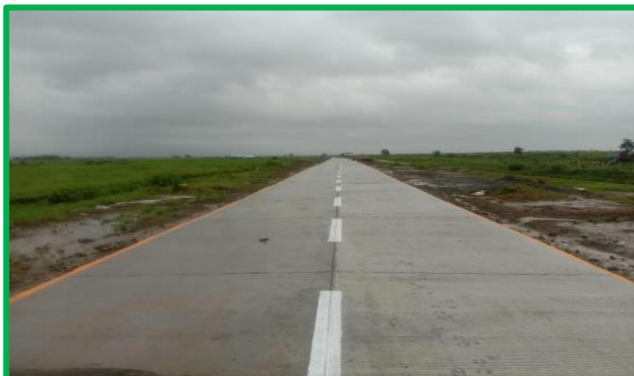
ကျောက်ပန္နူ-အင်းဒင်-စေတီပြင်တောင်ကျော်လမ်း (5.5m) အကျယ် ကွန်ကရစ်ထပ်ပိုးခင်းခြင်း
