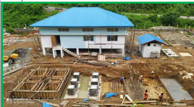
အမ်းမြို့နယ်၊ ဂဇုကိုင်ဓာတ်အားခွဲရုံ တည်ဆောက်နေပုံ
