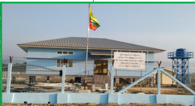
မောင်တောမြို့နယ်၊ ကြိမ်ချောင်းဓာတ်အားခွဲရုံ တည်ဆောက်နေပုံ
