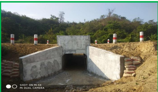
သက်ကိုင်ညာ-ပဒဂါးတောင်ကျော်လမ်း Box Culvert တည်ဆောက်ခြင်းလုပ်ငန်းဆောင်ရွက်နေပုံ
