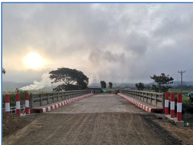
ကွန်တိုင်းတံတား တည်ဆောက်ပြီးစီးပုံ
