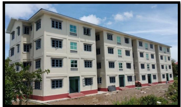
စစ်တွေဆေးရုံကြီးတိုးချဲ့(၄)ထပ် ဝန်ထမ်းအိမ်ရာတည်ဆောက်ပြီးစီးမှု
