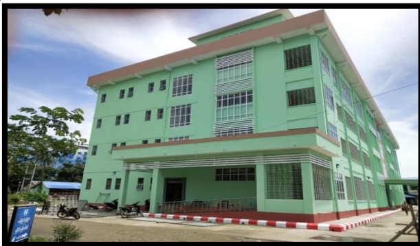
စစ်တွေအထွေထွေရောဂါကုဆေးရုံကြီးတိုးချဲ့(၄)ထပ်ဆောင်တည်ဆောက်ပြီးစီးမှု
