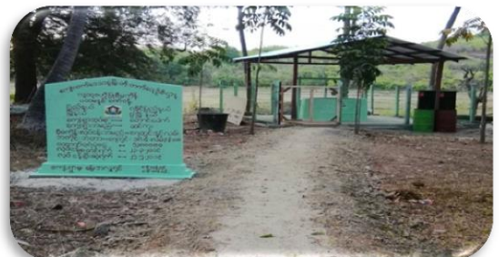
ဝဋ်မြို့နယ်၊ တောင်ပေါက်ကျေးရွာအုပ်စု၊ ဆင်ကူးကျေးရွာ ရေကန်ပြုပြင်ခြင်းနှင့် ရေစက်ရုံတည်ဆောက်ခြင်း
