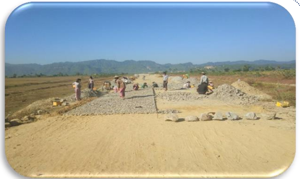
ကျောက်ပန္နု-အင်းဒင်-စေတီပြင်လမ်းဆောင်ရွက်နေမှု
