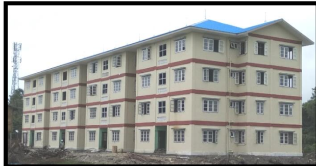
ကျောက်ဖြူပြည်သူ့ဆေးရုံ(၈)ခန်းတွဲ(၄)ထပ်ဝန်ထမ်းအိမ်ယာတည်ဆောက်ပြီးစီးမှု
